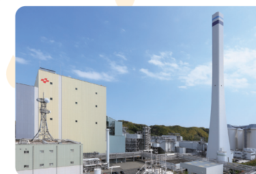
橋湾発電所 (徳島県阿南市)
