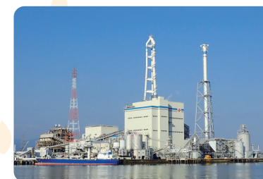
西条発電所 (愛媛県西条市)
