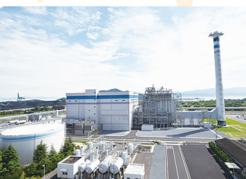
坂出發電所 (香川県坂出市)
