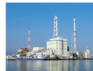
設備を高効率なものに置き換えた西条発電所
