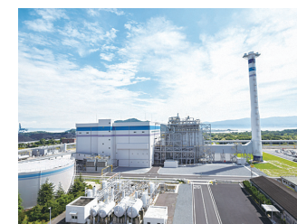
CO 2 排出量の少ないLNGを導入した坂出發電所
