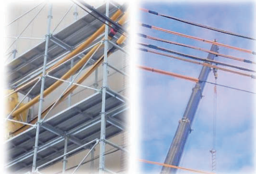
防護管取付箇所
