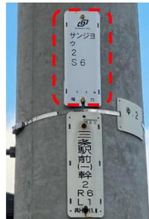
電柱の所有者の電柱札が上側に取付されています。
