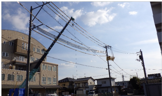
(例：施工後写真)
