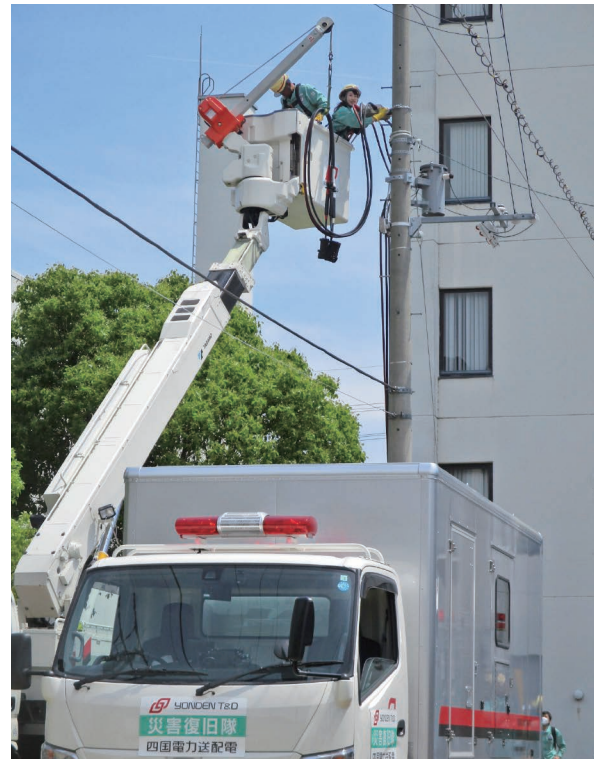
非常災害時配電設備復旧訓練
