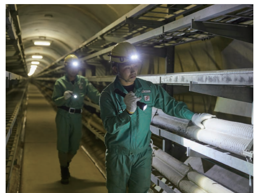
先輩社員同行のもと地中送電線を巡視
