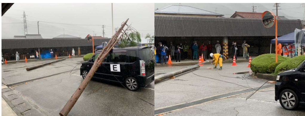
（道路啓開訓練の様子、倒木や倒壊電柱等の撤去作業）
