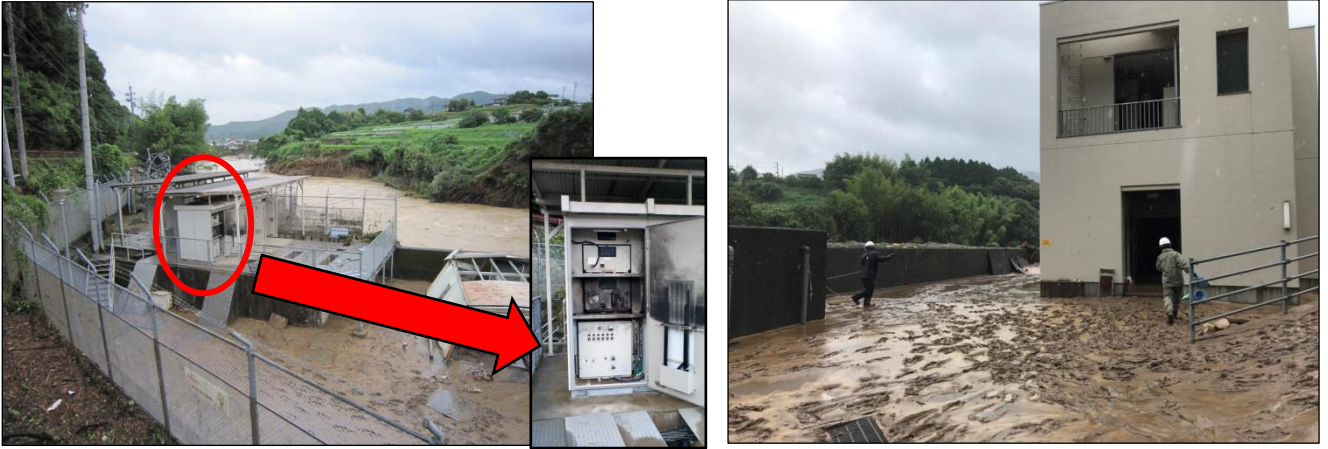
■ 変電所の被害状況（浸水のためショートした変電設備）
