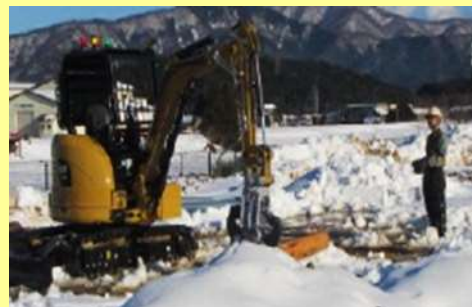
無線重機訓練
