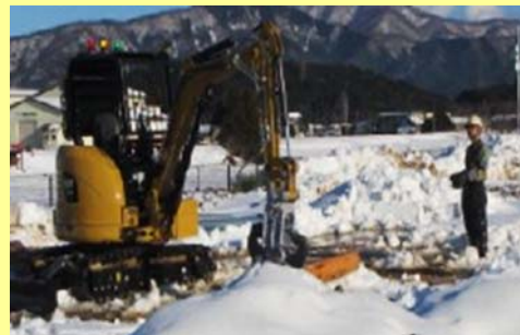
無線重機訓練
