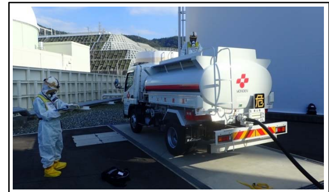
燃料補給作業
