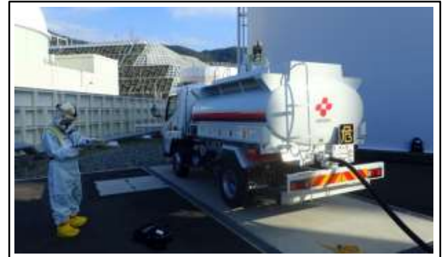
燃料補給作業
