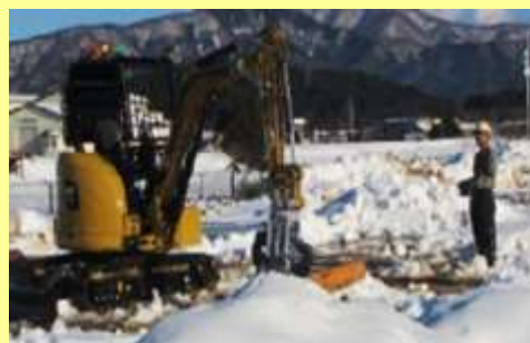
無線重機訓練
