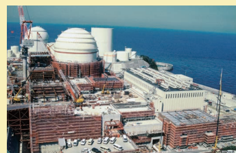
② 3号機建設工事
