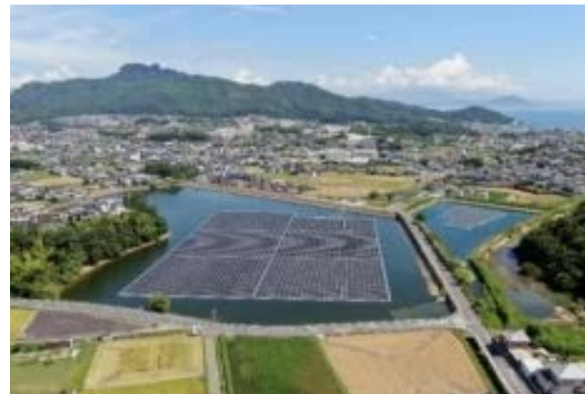
<水上太陽光発電所の開発実績>
