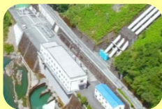
日野谷発電所
