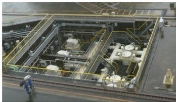
海水ピットポンプを竜巻による飛来物から防護するため、海水ピットポンプ室防護壁を設置
