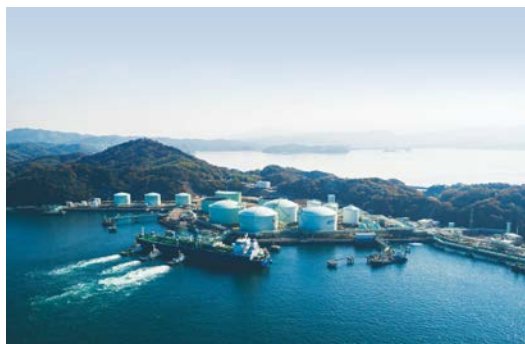
波方ターミナルの外観
