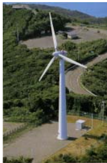
<当社室戸風力発電所>
