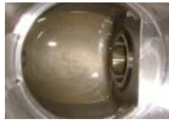
逆止弁 (3V-CS-136C) 異常なし
