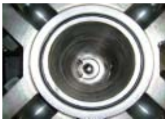
封水注入フィルタ 3 A 異常なし
