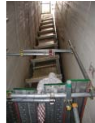
排気筒鉛直ダクト部 (外周コンクリート内側)
