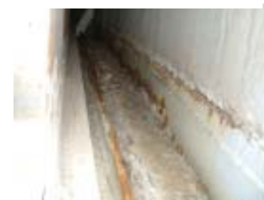
排気筒水平・鉛直ダクト部の接続 鋼材部(外周コンクリート内側)
