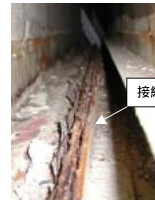
排気筒水平・鉛直ダクト部の接続 鋼材部(外周コンクリート内側)
