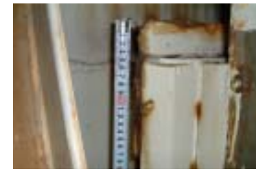
排気筒水平・鉛直ダクト部の接続 鋼材部(外周コンクリート内側)
