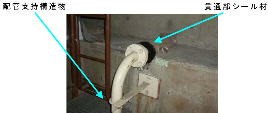
図－ 3 配管貫通部のシール施工例
