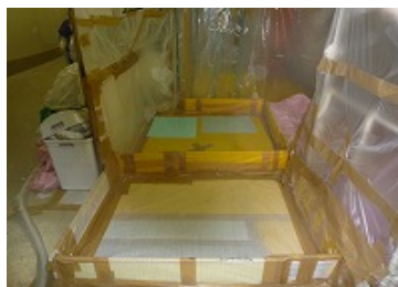
エリアの汚染防止のテープ養生の例
