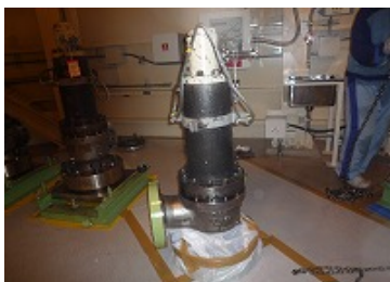
機器の破損防止のためのテープ養生の例
