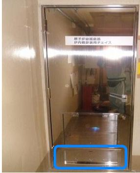
○格納容器下部の水位を確認するための原子炉下部キャビティ水位計を設置。
