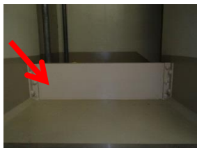
内部溢水による重要機器の水没を防ぐため、堰を設置
