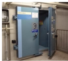
重要施設への浸水を防ぐため、水密扉を設置
