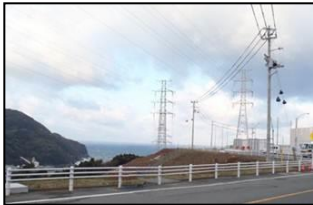
周辺の森林火災からの延焼を防ぐため、防火帯を設置
