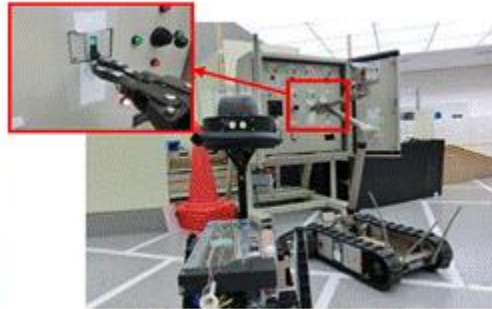
制御盤を開放しスイッチ操作
