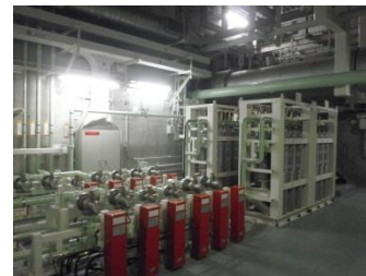
火災対策強化のため、異なる種類の火災感知器や自動消火装置を追加設置、耐火壁を設置
