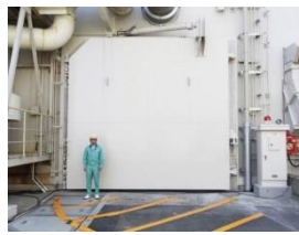
重要施設への浸水を防ぐため、水密扉を設置
