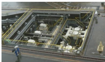
海水ピットポンプを竜巻による飛来物から防護するため、海水ピットポンプ室防護壁を設置
