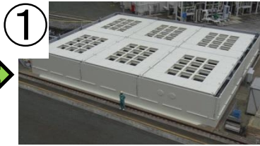
海水ピットポンプを竜巻による飛来物から防護するため、海水ピットポンプ室防護壁を設置
